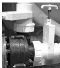
Scheibenventil und Pumpenanschluss
