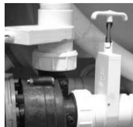
Scheibenventil und Pumpenanschluss
