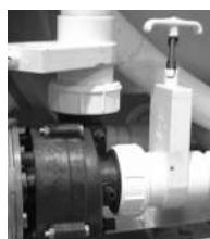
Scheibenventil und Pumpenanschluss
