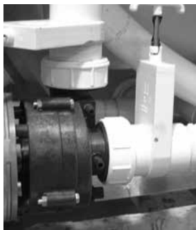
Vanne guillotine et raccord-union de la pompe
