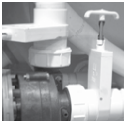
Scheibenventil und Pumpenanschluss
