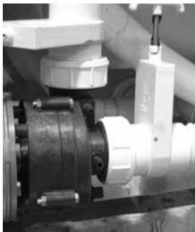
Scheibenventil und Pumpenanschluss
