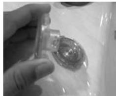
3. Si l'ensemble du jet à écoulement laminaire sort : rincez-le et examinez-le. Si seule la bague extérieure se détache : retirez l'insert intérieur du jet avec une pince à bec fin et examinez-le.
