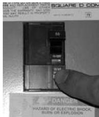
*Le disjoncteur GFCI doit se situer dans un boîtier étanche à proximité du spa, à une distance maximale de 5 pieds (1,5 mètre).*
