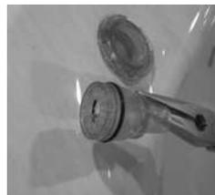
5. Réinstallez l'insert ou l'ensemble du jet et la bague extérieure en le poussant à l'intérieur et en tournant dans le sens horaire jusqu'à sa position de butée.
