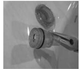
4. Reinigen Sie den Luftverteiler auf der Rückseite der Düseneinlage oder der Laminar Flow-Düsenbaugruppe, so dass alle Löcher frei von Verunreinigungen sind.
