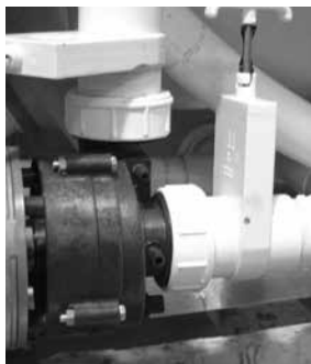
Vanne guillotine et raccord-union de la pompe
