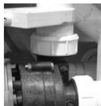
Vanne guillotine et raccord-union de la pompe
