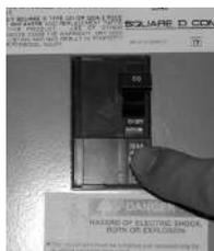
*Der FI-Trennschalter muss sich in einer wetterfesten Box in Sichtweite des Swimming-Whirlpool befinden, aber nicht nah am Swimming-Whirlpool befinden, um ihn direkt zu erreichen (nationale Elektrovorschriften und zugelassenen Elektriker konsultieren).*
