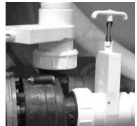
Scheibenventil und Pumpenanschluss
