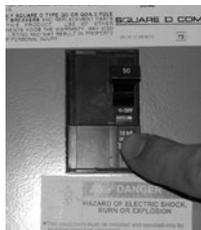
*Le GFCI doit être situé dans une boîte à l'épreuve des intempéries à portée de vue du bain, mais pas assez proche pour atteindre de l'intérieur du bain (consultez NEC et électricien agréé).*
