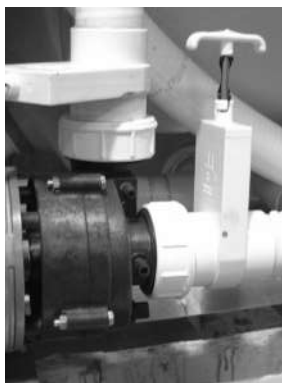
Vanne de coupe et raccord de pompe
