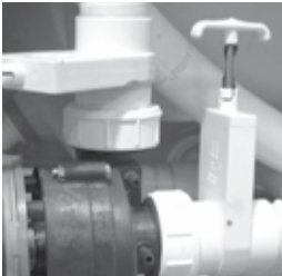
Scheibenventil und Pumpenanschluss
