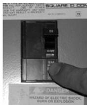
*Le disjoncteur GFCI doit être situé dans une boîte à l'épreuve des intempéries près du bain à remous, mais à une distance minimale de 12,7 cm (5 pi).*
